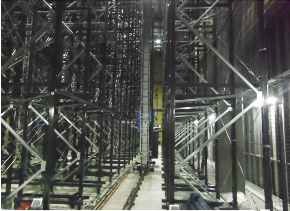
● 増築2階部分 自動倉庫
