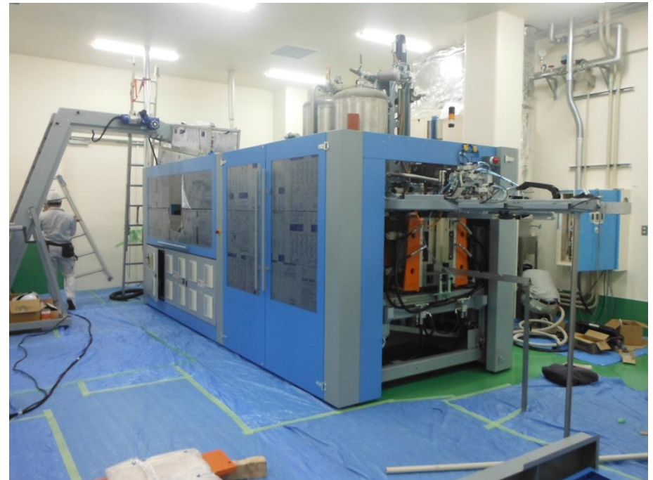
●増築1階成形機室
